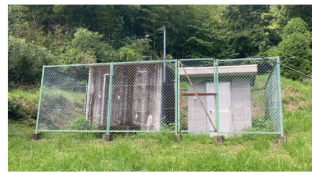
山間地の水道施設
