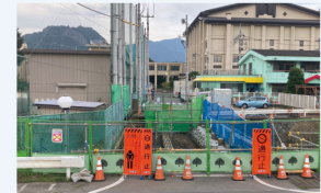
大月保育園前水道 現在工事中
